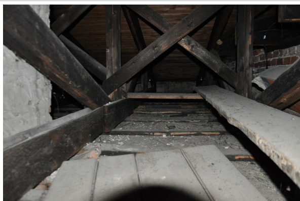
PUSTKA POWIETRZNA STROPODACHU
